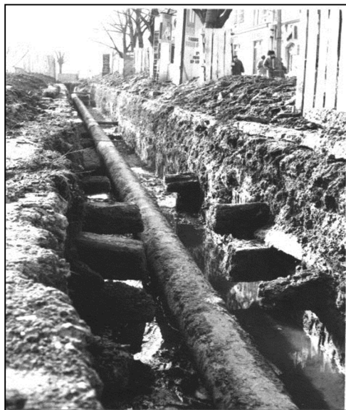
9. ábra: Az egykori Nagyhid feltáruító gerendái egy közműépítésnél 1975-ben
